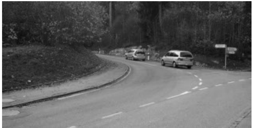
Eine Sanierung ist ab der Verzweigung Orvin nötig.
