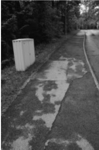
Bushaltestelle Kapellenweg – Hochschule Lärchenplatz.
