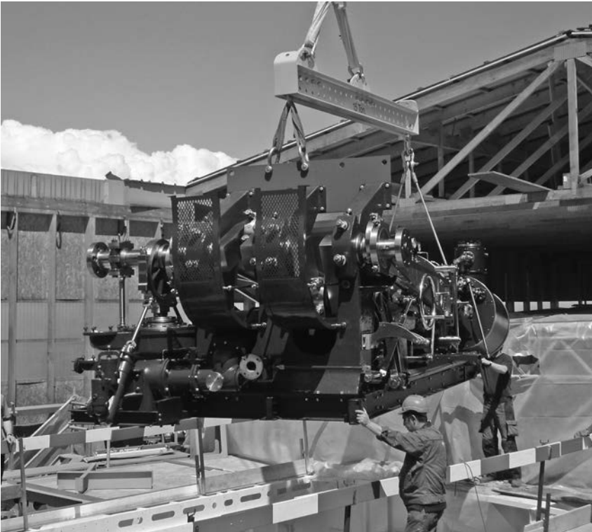
Die neue Maschine wird gesetzt.
