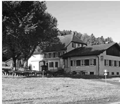
Das End der Welt – jetzt ein BASPO-Gebäude.
