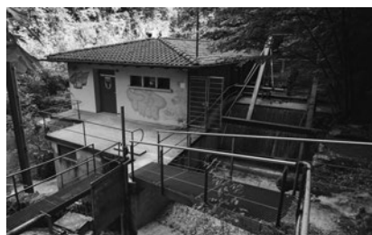
20. Kleinkraftwerk, Taubenloch, Frinwillier
