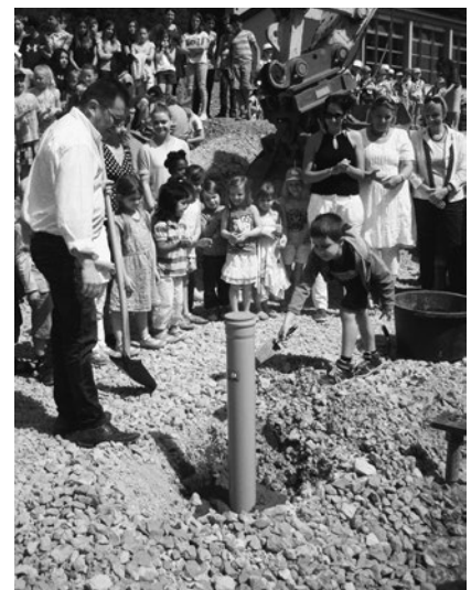
Das Rohr wird einbetoniert.
