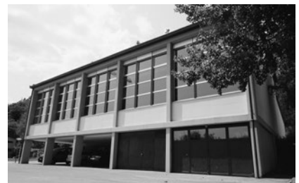
10. Turnhalle, Ch. des Voitats 4A, Leubringen
