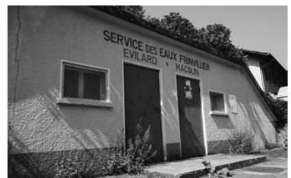
21. Wasserversorgung, Taubenlochweg, Frinwillier
