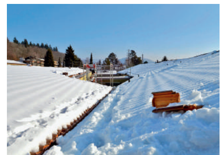
Auf dem Dach wurde die Ziegeleindeckung noch vor dem ersten Schnee vollendet. Die Dachflächen fließen in der Dachkehle zusammen.
