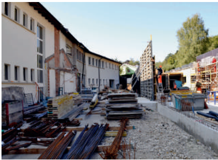
Die ersten Sichtbetonwände des Erdgeschosses sind betoniert.
