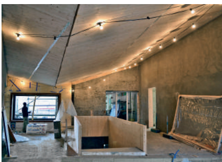
Mit der ersten Baustellenbeleuchtung kann der Innenausbau beginnen.
