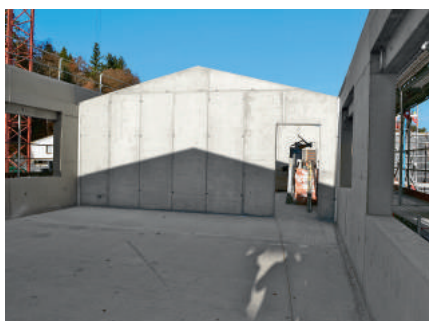
Die Wände der Klassenzimmer im Obergeschoss stehen. Das erste Openair-Klassenzimmer ist eröffnet.
