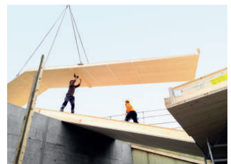
Die vorfabrizierten Holzdeckenelemente werden mit dem Kran an die richtige Position gehoben.
