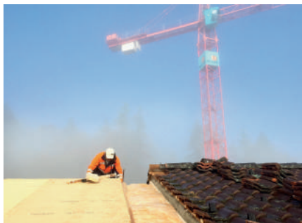
Die neuen Dachziegel werden nahtlos vom bestehenden auf das neue Dach weiterlaufen. Zuerst werden die Dachelemente noch ausgedämmt.
