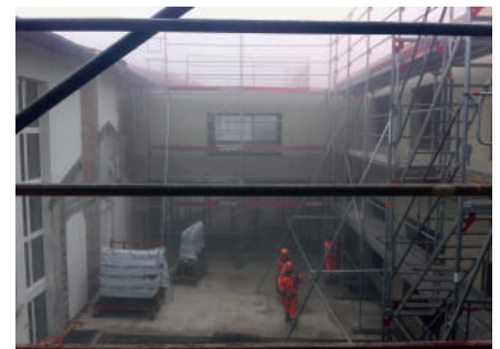
Auch die beiden Passerellen zwischen Altbau und dem Neubau sind fertig gestellt. Von ihnen aus sieht man direkt in den Innenhof hinunter.
