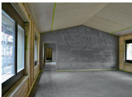
Die Klassenzimmer erhalten ihre Fenster. Nun ist das Gebäude dicht.
