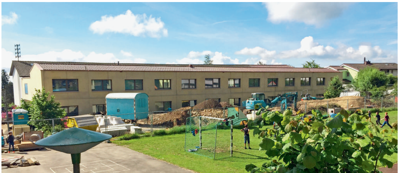
Das neue Gebäude verläuft parallel zum Altbau und streckt sich über die ganze Länge des Fussballplatzes. Schon bald werden die Schulkinder wieder auf diesem spielen können.
