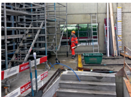
Im Westen der Schulanlage hat die neue Treppenanlage das 1. Obergeschoss erreicht.
