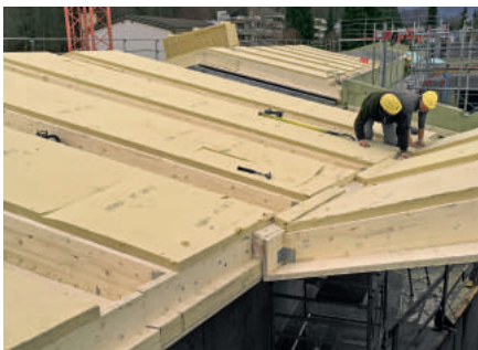
Der Betonneubau erhält sein Holzdach.
