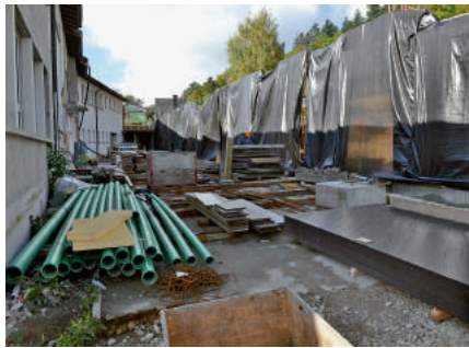
Die Sichtbetonwände müssen sofort vor zu schnellem Austrocknen geschützt werden.
