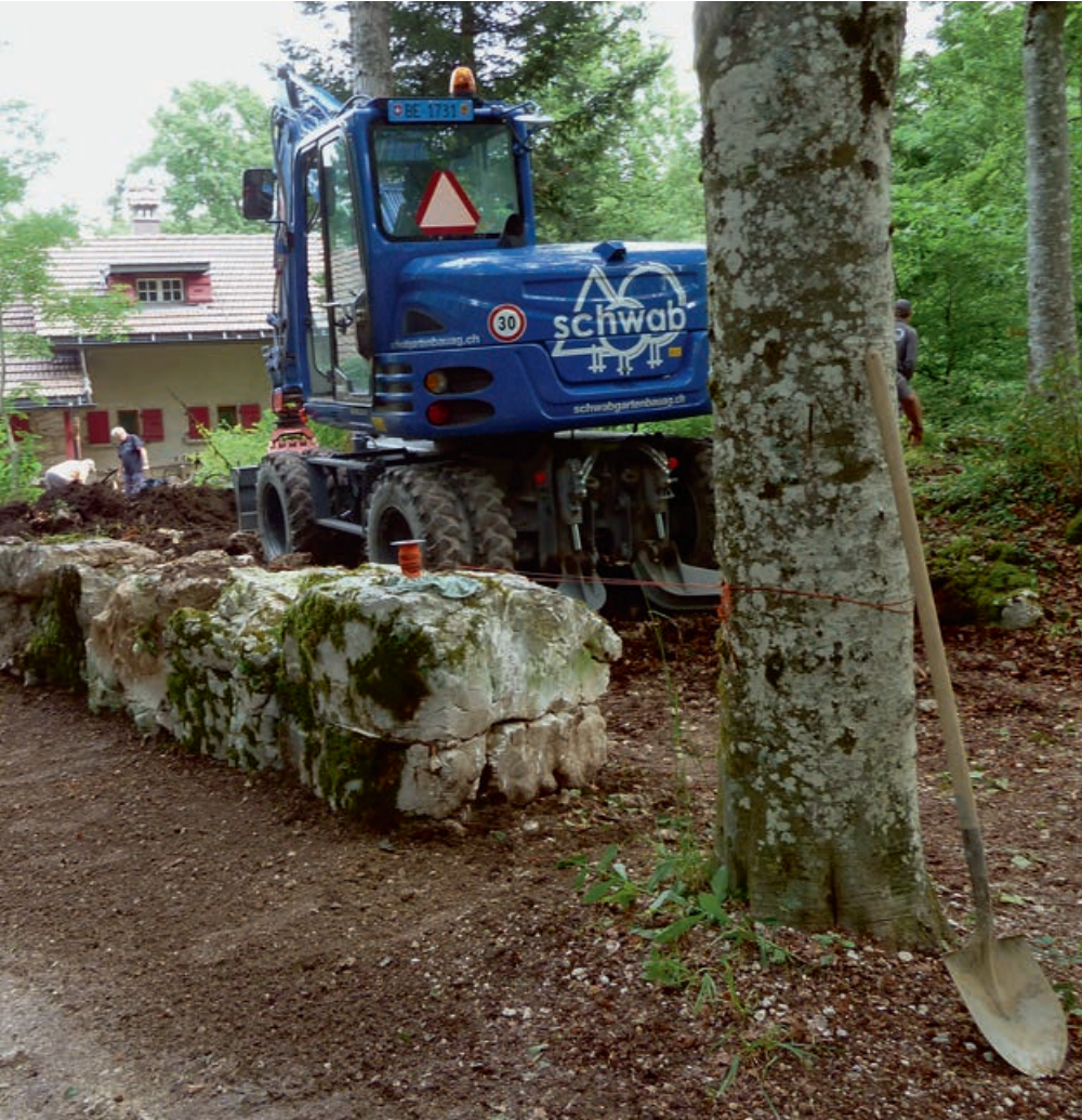
Im Juli noch eine Baustelle ....
