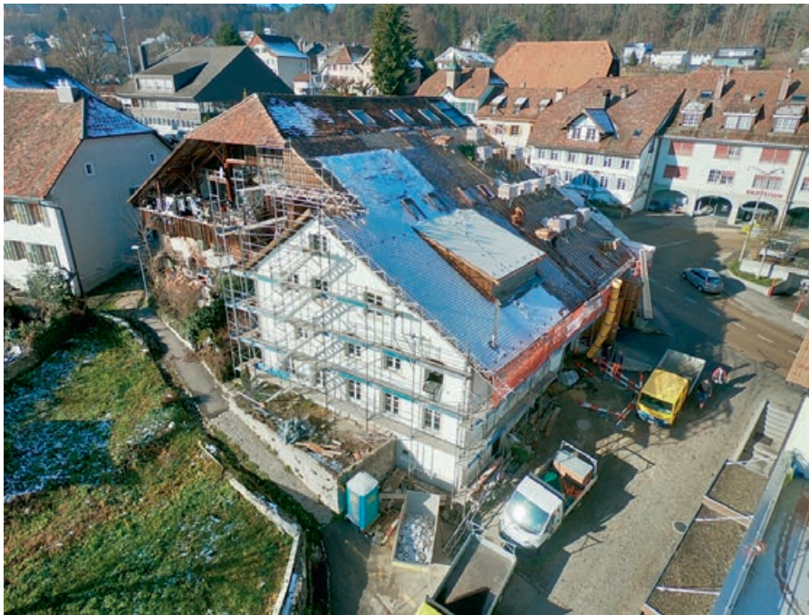
Renovation des Daches und Einbau der neuen Lukarne.
