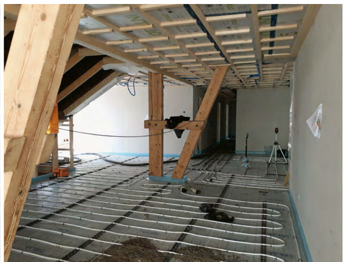
«5.5 Zimmer Wohnung mit Bodenheizung vor Einbau Unterlagsboden»
