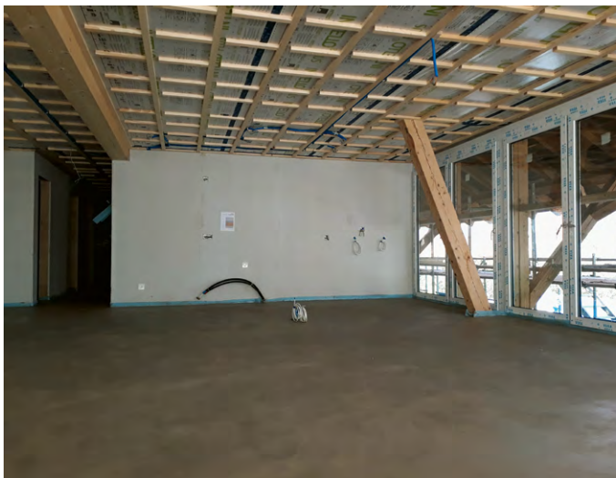
«Wohnbereich 4.5 Zimmer- Wohnung im Rohbau»
