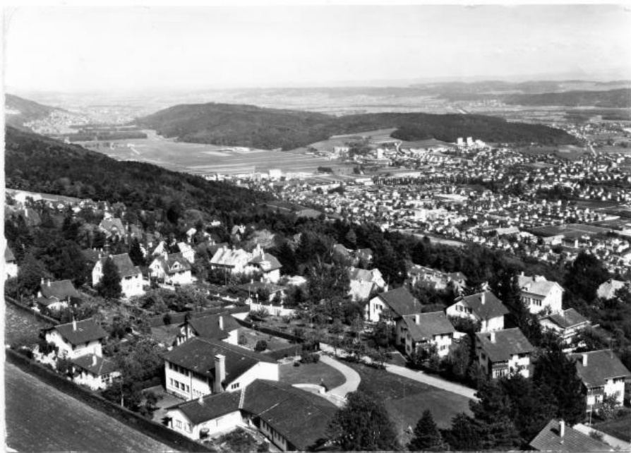
Evlard, vue aérienne direction Bienne est / Leubringen, Luftbild Richtung Biel Ost 12.07.1974
