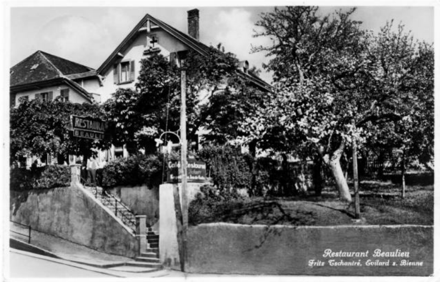
Restaurant Beaulieu, Fritz Tschantré, Evillard s. Bienne 27.10.1927
