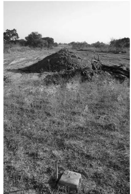
*Les bornes placées par les géomètres permettent à l'entrepreneur de construire le barrage selon les plans dessinés par les ingénieurs.*
