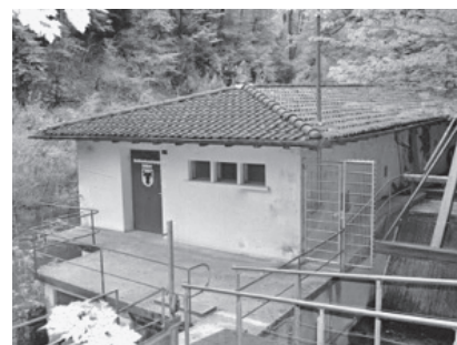
Notre petite centrale électrique à Frinvillier.
