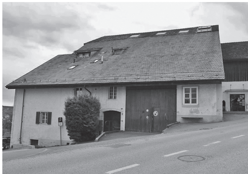
La maison située au Neu'Chemin 2 doit être rénovée.
