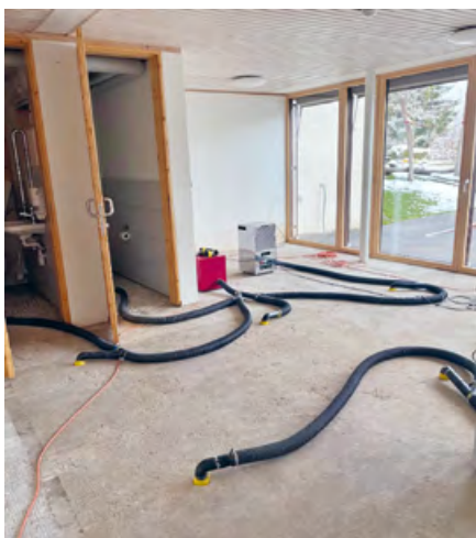
Sanierungsarbeiten in der Kindertagesstätte Evilard
