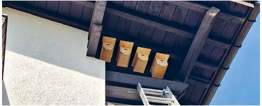
Kindertagesstätte Leubringen: neu installierte Nistkästen für Mauersegler
