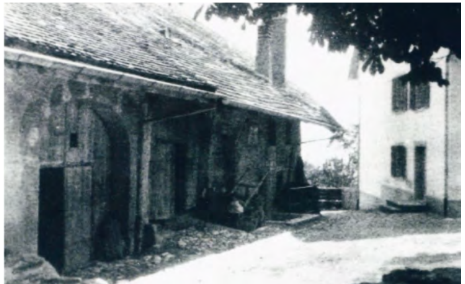
Façade est de la Baume 1, dans les années 1700
