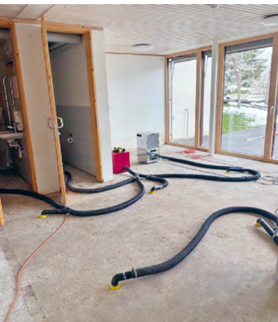
Travaux d'assainissement à la crèche d'Evilard
