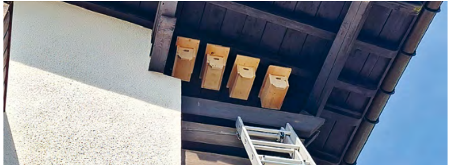
Nichoirs pour martinets installés sur la crèche à Evilard
